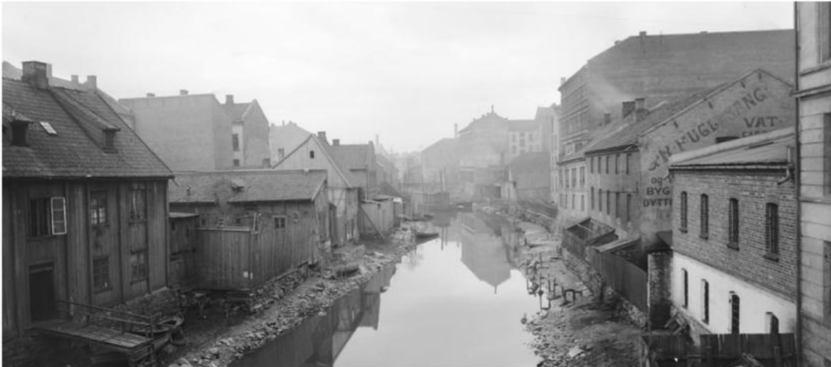
Bilde tatt fra Hausmanns bro mot Vaterlands bro. På gavlveggen til høyre skimtes navnet G.R. Fuglesangs. Ca. 1900. Foto: Marthinius Skøien. Eier: Nasjonalbiblioteket.
